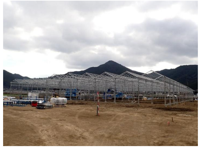
嬉野市園芸団地の施工状況
