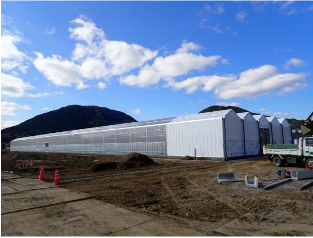
武雄市園芸団地の施工状況
