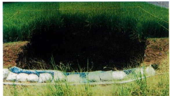
水田に発生した浅所陥没事例
