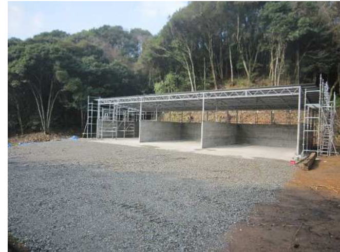
堆肥舎（H31.3竣工）
