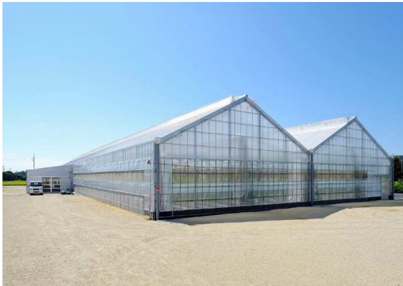
トマトハウス全景（環境制御型ハウス 2,028m）
